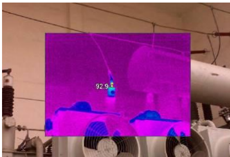
变压器接线桩头接触不良
